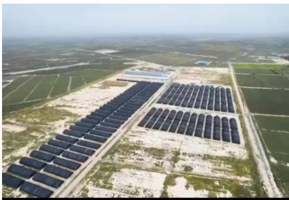
新疆维拓生物科技有限公司-食用菌产业园
