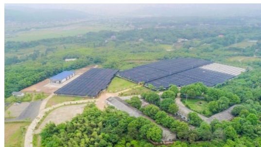
韶山银田村乡村振兴产业园
